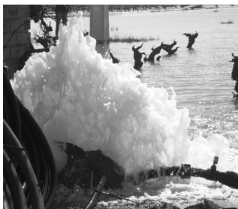
Figura 6. Aspecto de la surgencia.
