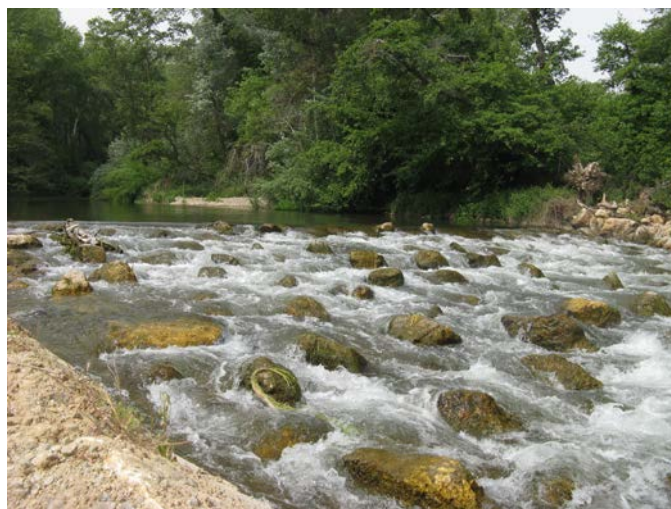
Figura 1. Rampa para peces en el río Najerilla (Torremontalbo, La Rioja). Foto: Pedro Boné.
