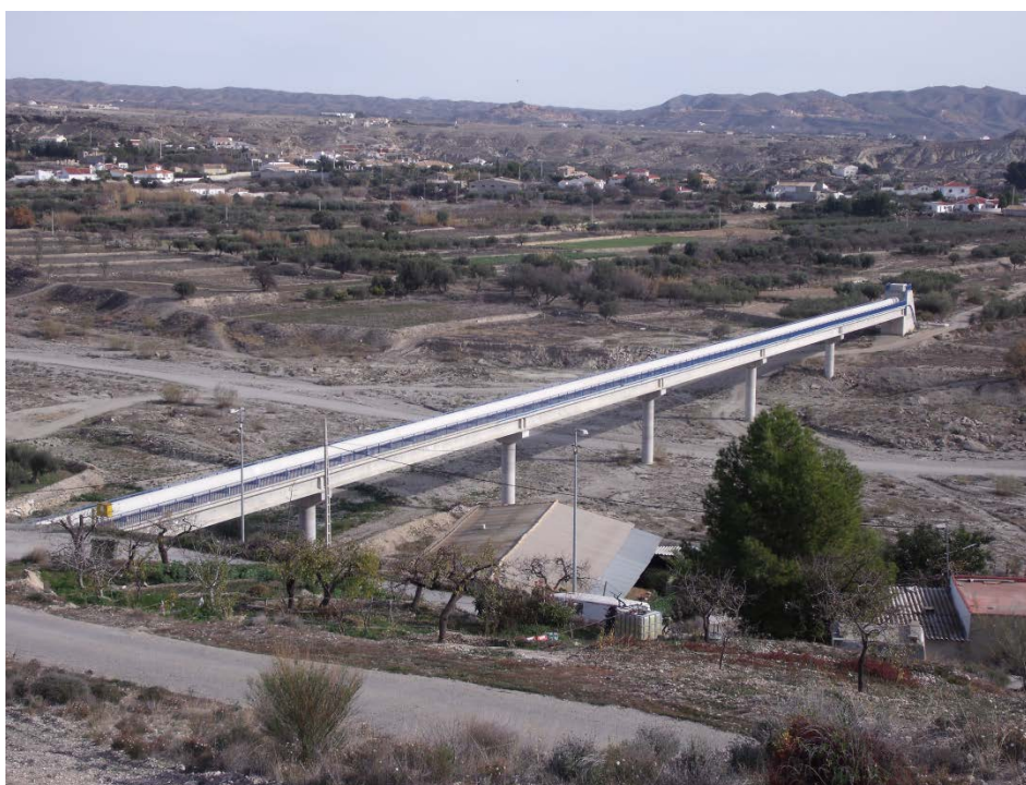
Figura 3. Acueducto de la Conexión Negratín-Almanzora a su paso por la rambla de Albox (Fuente: Los autores).
